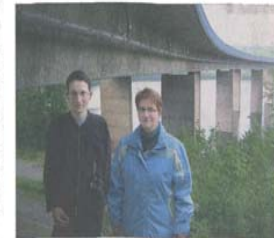
Arndt Wellbrock und Klaudia Witte wollen die Gewohnheiten der Mauersegler in der Talbrücke Ronnewinkel erforschen.
